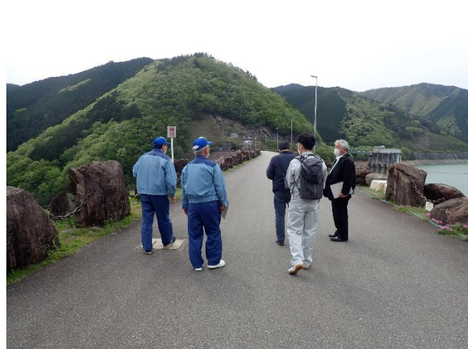
ダム堤頂道路点検状況
